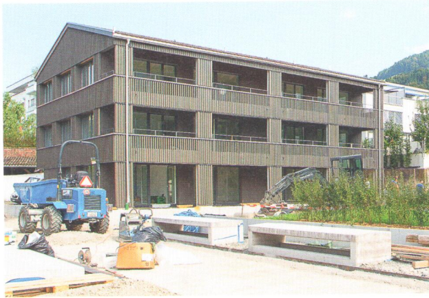
Satteldach und Holzfassadenbekleidung aus sägeroher Fichte und Tanne
