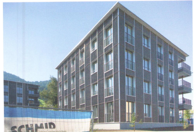
Elegantes Flachdach und fein profilierte Metallfassade
